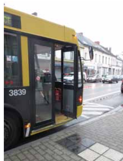
L'arrêt accessible est équipé de dalles podotactiles en tête de quai, pour signaler l'accès à la porte avant pour la personne déficiente visuelle.
