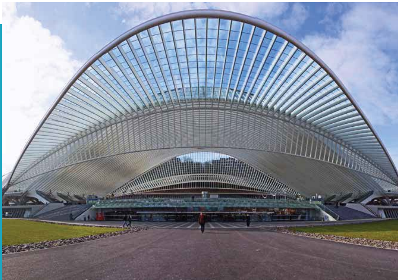
La gare de Liège-Guillemins
