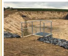
Bassin de rétention en zone agricole. La zone de stockage est située au niveau de l'arrivée des eaux et permet de limiter le risque d'effondrement des berges.
