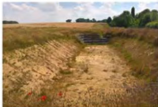
Bassin de rétention en zone agricole. La zone de stockage est située au niveau de l'arrivée des eaux et permet de limiter le risque d'effondrement des berges.
