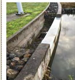
Exemple de surverse de sécheresse
