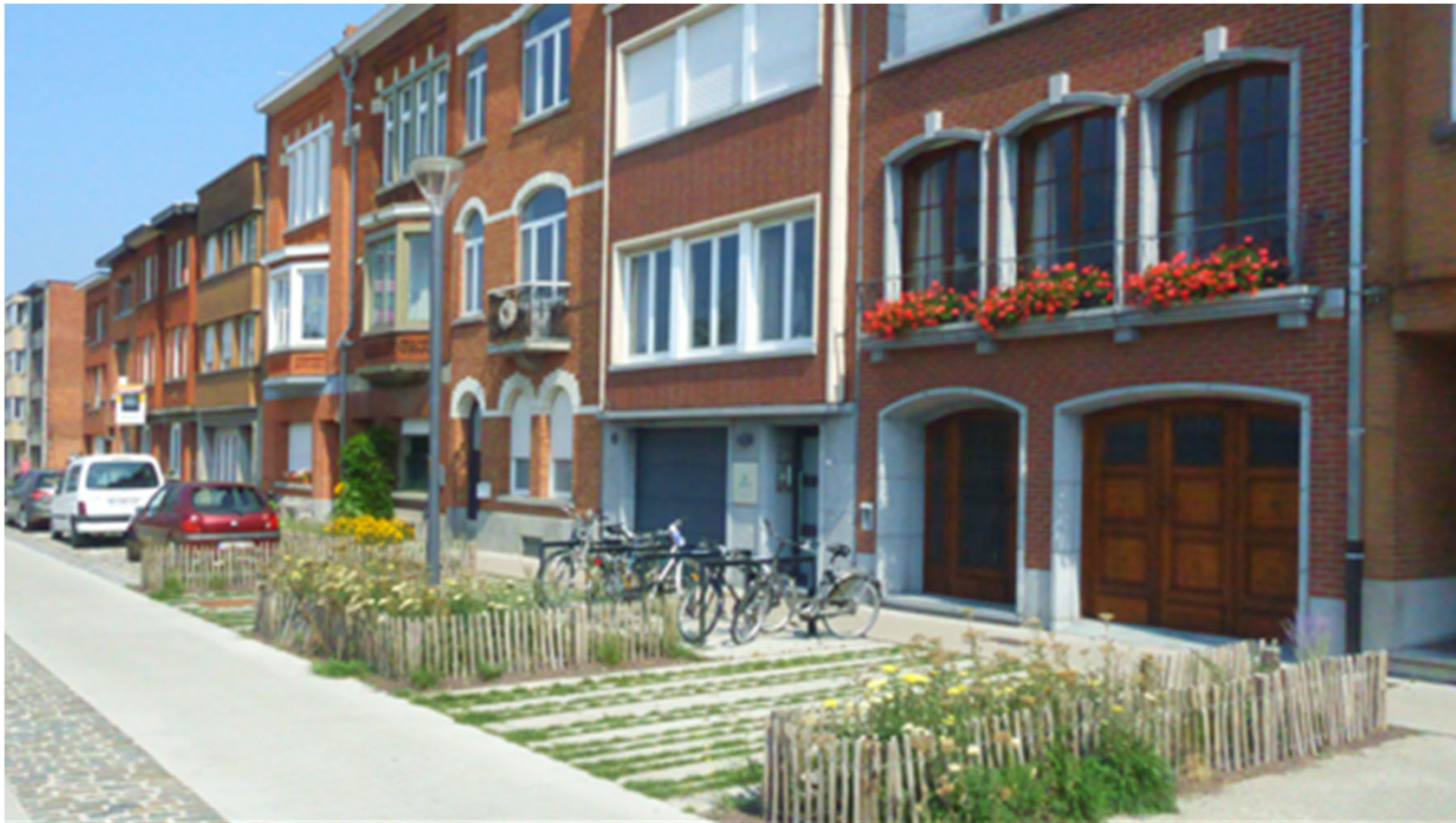
Illustration: à Louvain en face du Parc Belle-Vue, la végétalisation des entrées de garage permet de limiter l'imperméabilisation du sol tout en assurant une transition entre les espaces public et privé. Crédit photo : S. Verels- CPDT – Vademécum: Infrastructures vertes, pourvoyeuses de services écosystémiques, 2020
