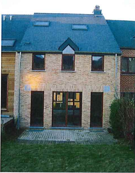
maison unifamiliale existante
