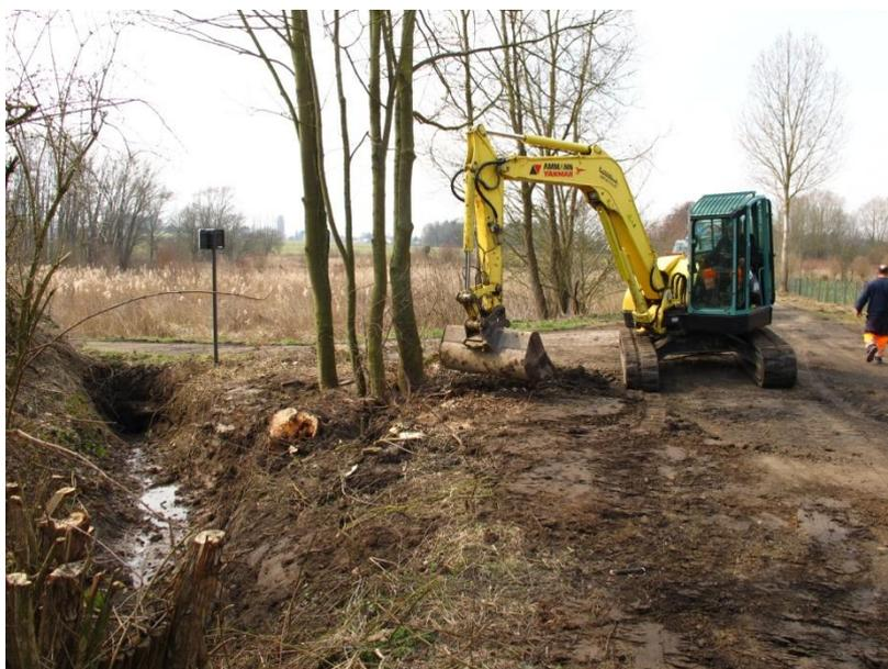
Photo 7 - Curage des fossés et nettoyage des entrées de canalisation
